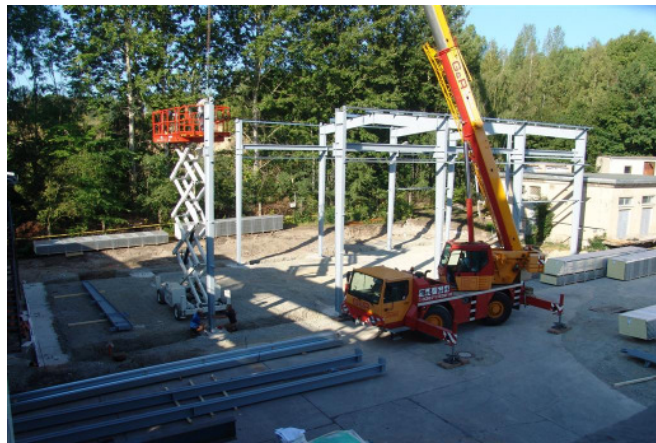
Baufortschritt bei IBU-tec (August 2009)
